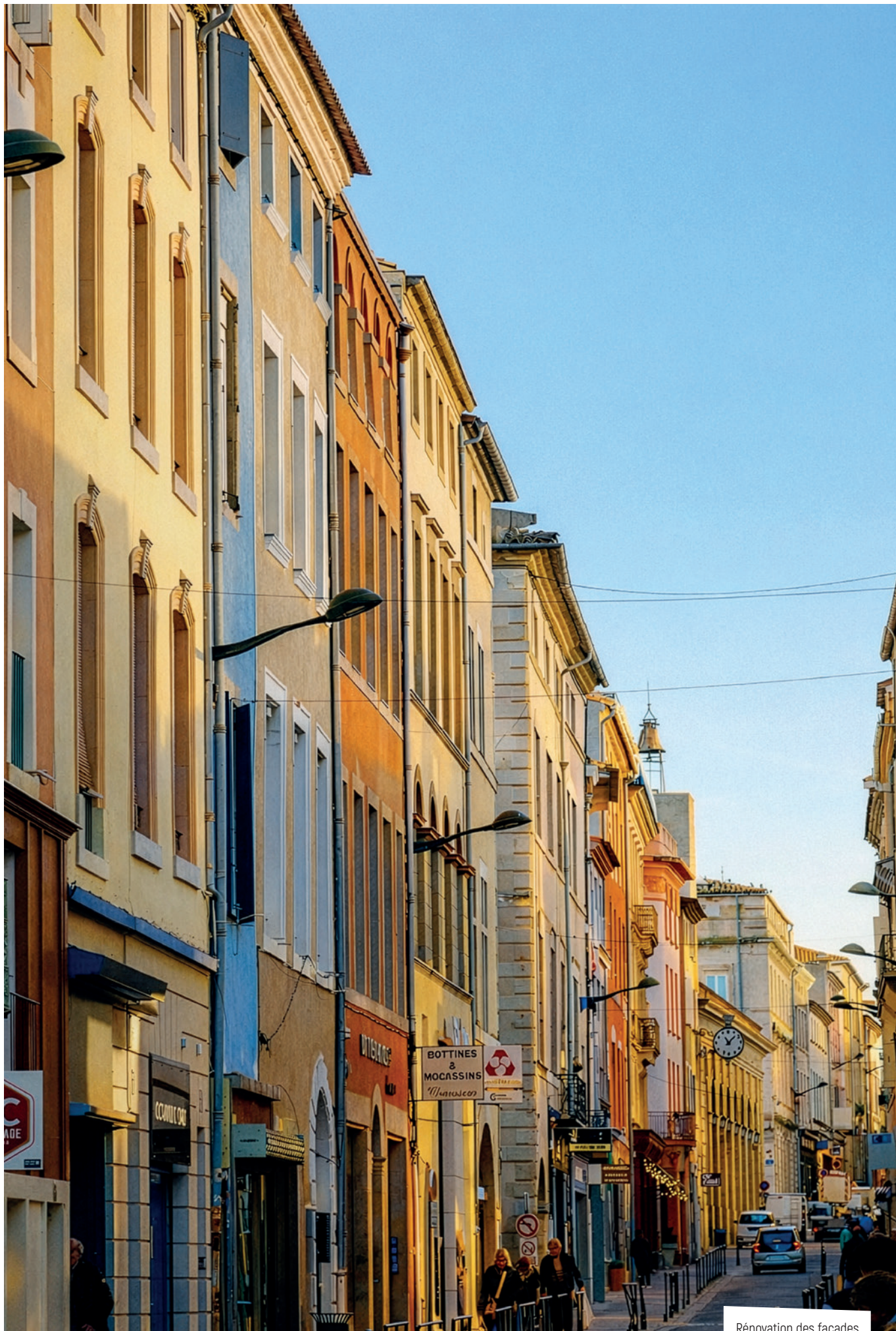
Rénovation des façades
